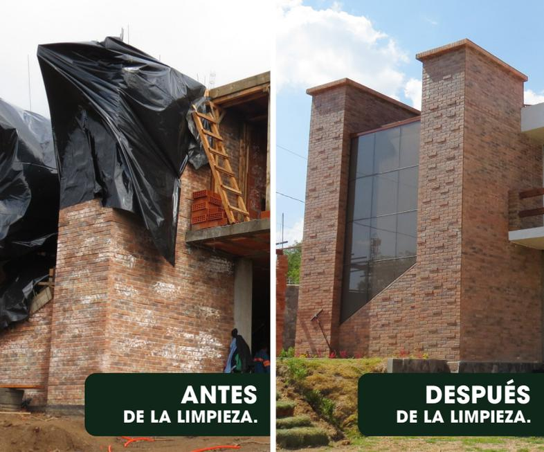
y concreto son inexistentes y solo tiene que limpiar manchas de eflorescencias, de mortero de pega y emboquillado.
